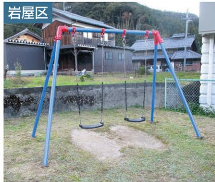
ブランコ・滑り台・鉄棒の腐食部分や錆びた部品等を取替え・塗装
