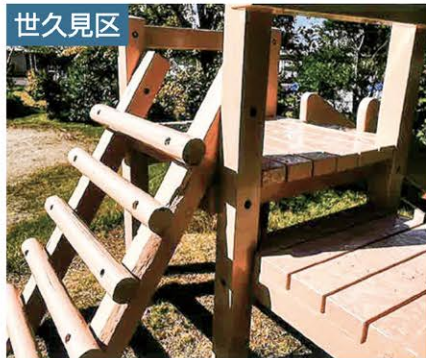
滑り台の腐食部分や床板を取替え・塗装
